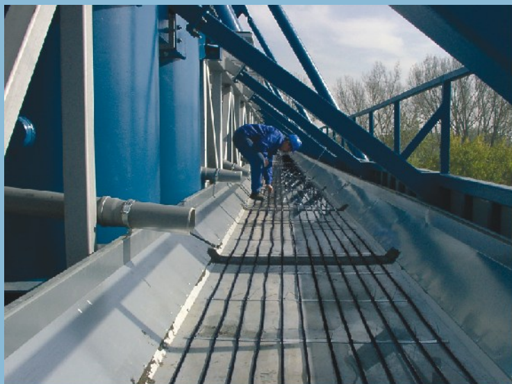
Przykład ułożenia przewodów grzewczych w korycie dachowym
