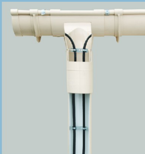
Mocowanie przewodów grzejnych w rurze spustowej przy pomocy taśmy montażowej ELEKTRA TMS
